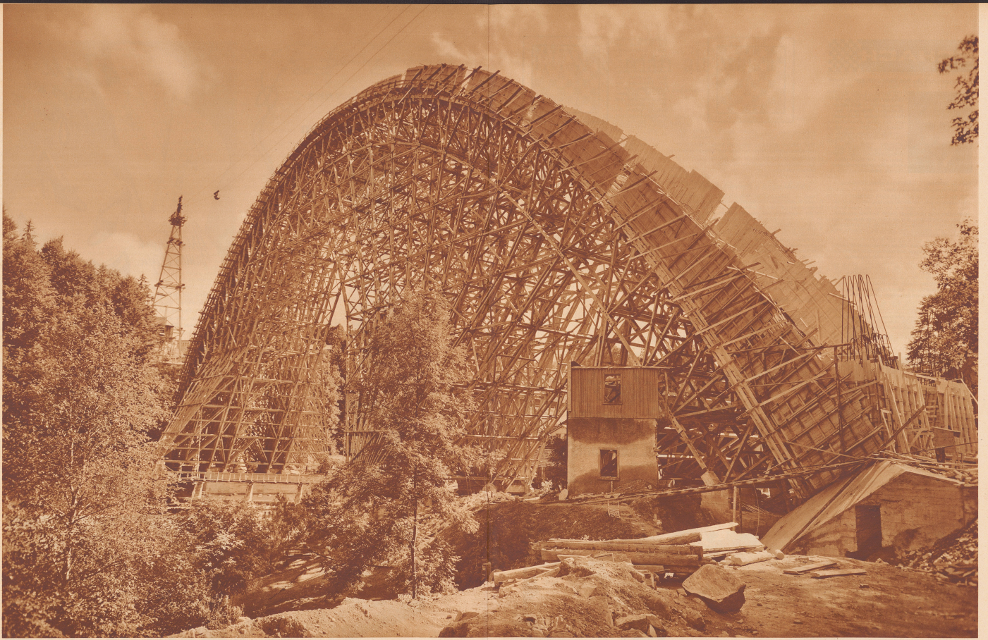
Der große Bogen. Das ist das mächtige Hölzgerüst aus Holz, das zum Bau der weitgespannten Bogens der neuen Strassenbrücke bei St. Gallen errichtet werden mußte. Diese Brücke, die den Abhang des Zugangs von Wetzten zur Stadt St. Gallen überbrückt, wird die größte Straßenbrücke Europas in Eisenbeton sein. 135 Meter weit und 67 Meter hoch wird der Zwillingsrippenbogen des Stützgerüsts überspannt. Die ganze Länge der Brücke beträgt 550 Meter, die mittlere Breite 14 Meter. 6000 Cantoneisen, 4000 Tonnen Zement, 4000 m 3 Gerüstholz, 1100 Tonnen Ankerriegelstangen werden für den Bau der Brücke benötigt. Die Bauzeit dauert drei Jahre, während welcher Zeit ständig 30-100 Arbeiter Beschäftigung finden. Die Baukosten belaufen sich auf 3 450 000 Franken.
