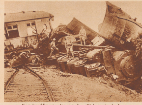
Eines der schlimmsten Attentate dieser Räuberbande: der Anschlag auf offener Strecke auf einen internationalen Expresszug der Linie Chaihu-Mukden. Un des plus sinistres exploits de la bande: le déraillement de l'express international Chaihu-Mukden.
