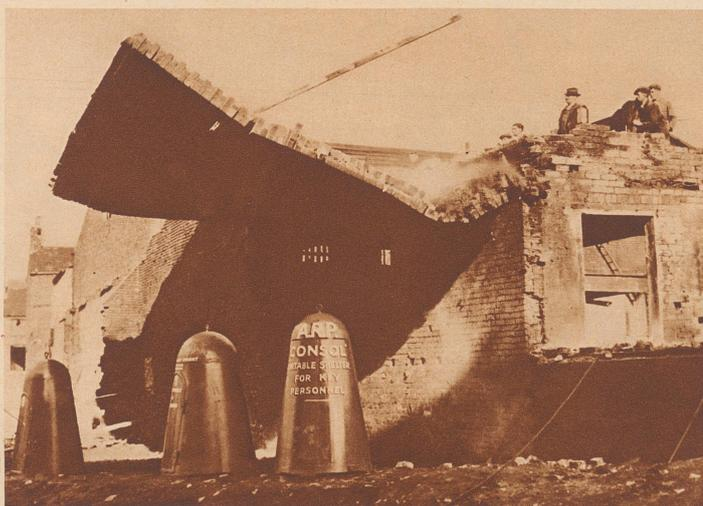
Ahnliches in Birmingham: Eine Anzahl schußfester Luftschutzstahlkegel sollen als transportable Luftschutzräume verwendet werden. Man unterzog sie einer besonders harten Materialprobe unter der Einsturzwanne eines Abbruchhauses. Schutt und Ziegel stürzten auf die Kegel hinab, die sich jedoch glänzend bewährten und nicht beschädigt wurden.
