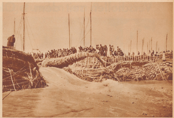
Der Dammbau geht seinen Ende entgegen. Eine Lücke von 10-12 Meter Breite ist noch zu schließen. Mit großer Wucht schließt das Wasser durch die Öffnung; darum ist diese Endphase die schwierigste Stück Arbeit. Eben wird eine der letzten mächtigen Fäden als sogenanntes Seilnetz ins Wasser gelassen. Diese Fäden sind hergestellt aus 12-15 Meter langen Weiden, ausgefüllt mit Erde und Kien und zusammengehalten mit dicken, auf drei Meter gestrichelten Stricken. Zehntausende von toden Fädenwurden wurden bei diesem Dammbau zum Schutz des Lehmkerens benötigt.
