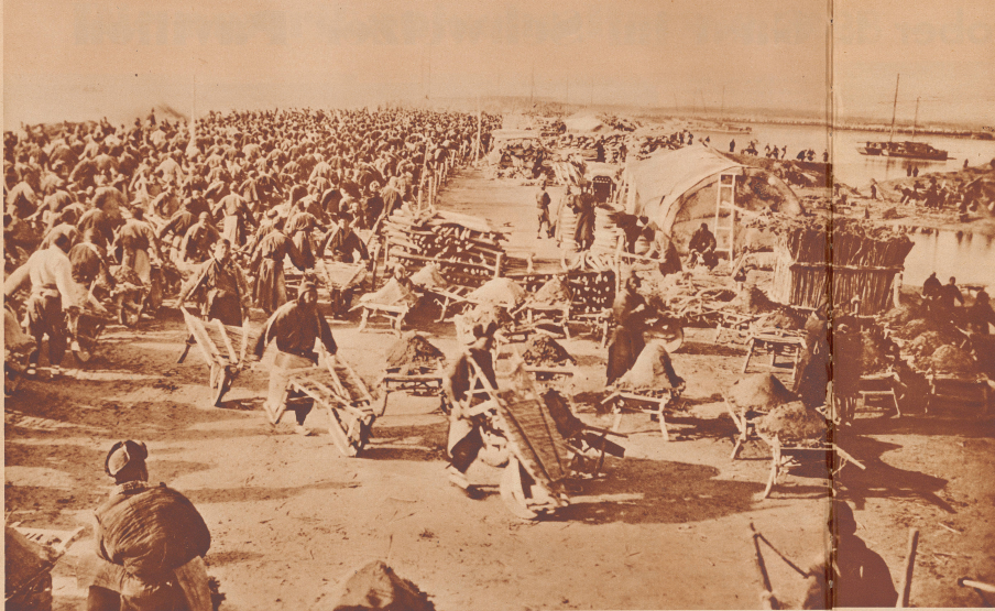
Da kann man schon sagen: es winnelt wie in einem Ameisenhaufen. Zehntausende von Kulis waren bei diesem Dammbau beschäftigt. Ohne Motorenkraft, ohne andere moderne mechanische Hilfsmittel wird Schicht um Schicht die riesige Erde herbeigeführt. Rechts eine der Strohmaschinen, die während des Bauens den Kulis die Arbeit erleichtern.
