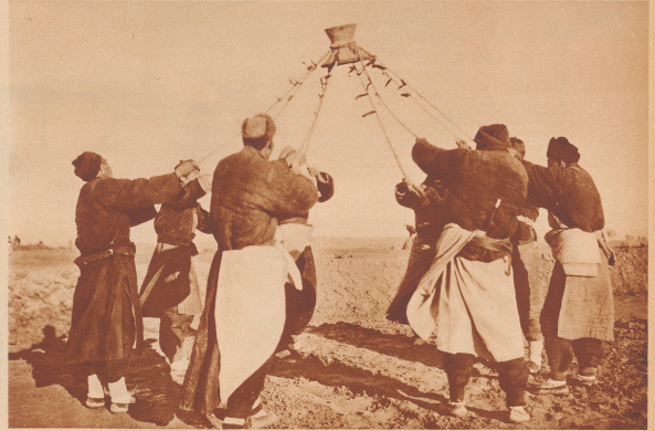
Der »Adernanzubilliger« in Tätigkeit. Ein uraltes Instrument, mit dem der Damm »festgezurrt« wird. Acht Mann schleudern den ungefähr 60 Kilo schweren Schläger an 3 Meter langen Seilen in die Luft und lassen ihn auf die Erde niederfallen. Rund 2 Millionen Kubikfuß Erde wurden so bei diesem Dammbau nicht der Dampfwalze, sondern von Hand festgestampft.
