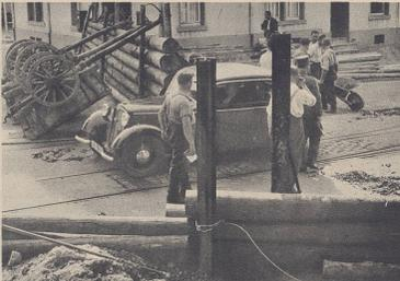
Sperre einer breiten Hauptverkehrsader mittels T-Balkenfüßen und Baumstammbarrikade. Die Straßenbahn verkehrt noch einseitig, und für die Automobile ist nur eine schmale Passage freigelassen. Fermeture d'une grande voie de circulation au moyen de poutres en fer et de troncs d'arbres. Le tramway circule encore sur une voie et un étroit passage est réservé aux automobiles.
