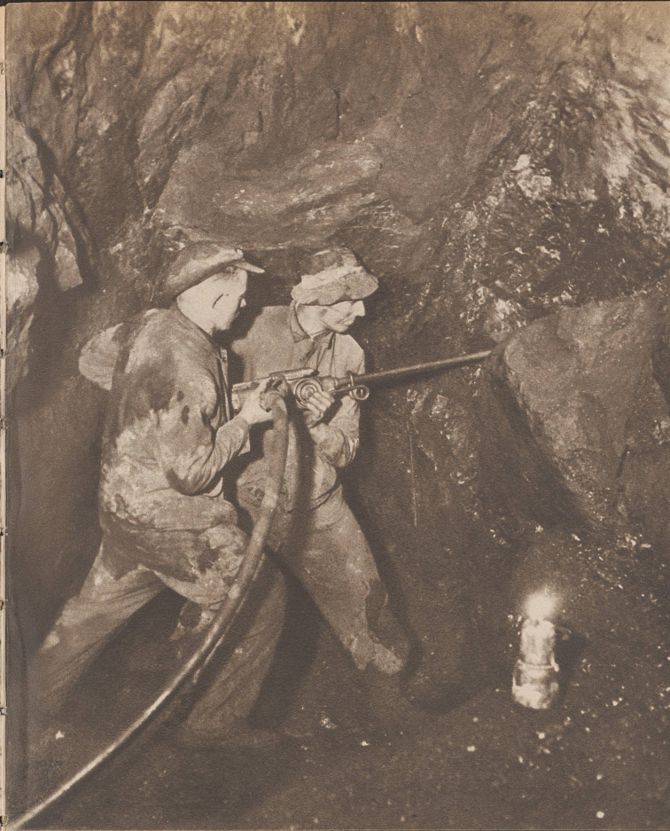
Zwei Oberländer Bergleute an der Arbeit vor Ort mit dem Bohrhämmer. Augenblicklich sind mit der Gewinnung von Kohle im Tag- und Nachtschichtbetrieb etwa 35 Arbeiter beschäftigt. Deux «hommes noirs» de l'Oberland maniant la perforatrice. L'exploitation occupe 35 ouvriers qui travaillent jour et nuit.
