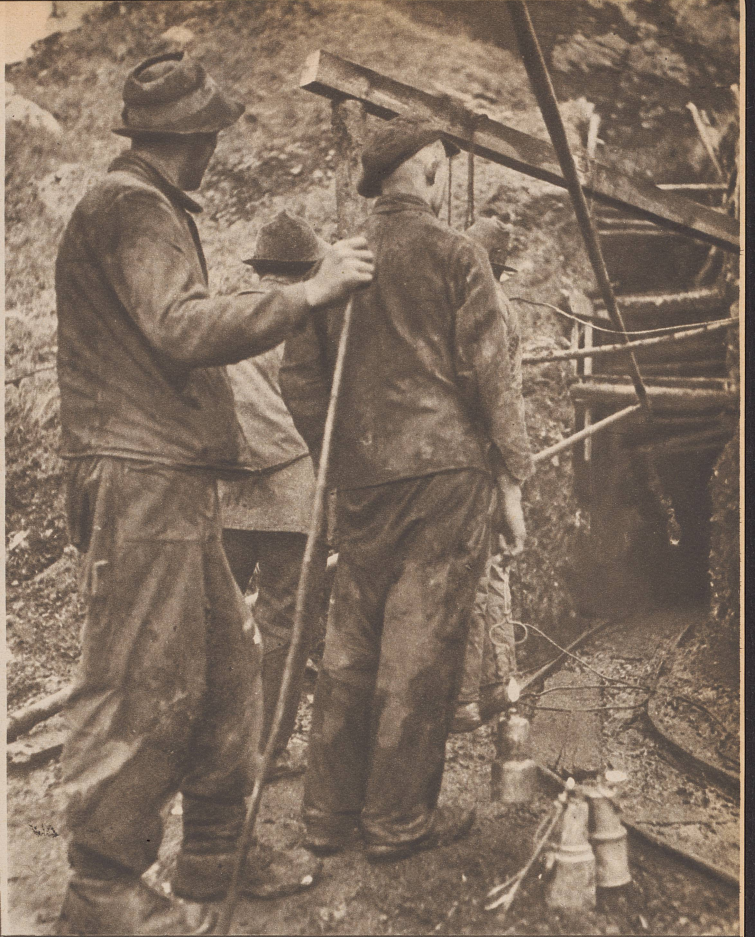
Das Brechen der Kohle am Flöz erfolgt durch Sprengung. Die fünf Hauer haben den 100 Meter tiefen Stellen verlassen und warten darauf, bis eine Sprengladung losgegangen ist. Gegenwärtig werden täglich 15–20 Tonnen gefördert. Une mine a été posée. A l'entrée de la galerie, les ouvriers attendent que se produise l'explosion.
