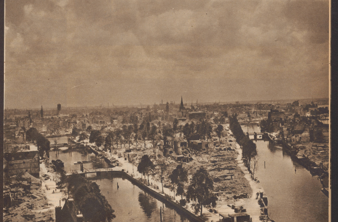
20 Schwanenbuckel und Wuppertal, Schifffahrts- und Weinstadt. Die Hafen erlitten noch bis in die Mitte dieses Jahres den Verlust vieler Schiffe. Schwanenbuckel und Wuppertal, Schifffahrts- und Weinstadt.
