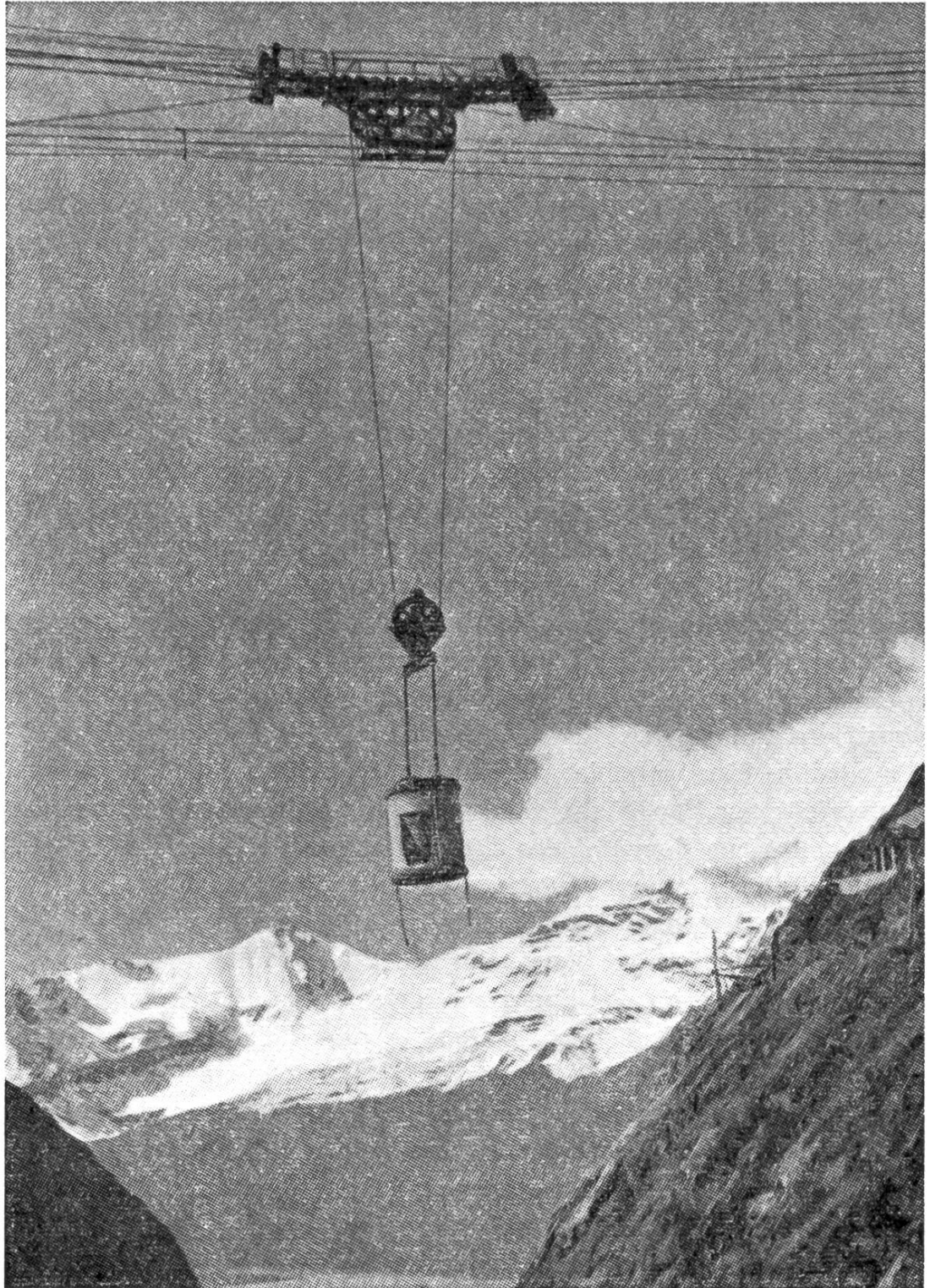
Kabelkrane verteilen den Beton auf der ganzen Baustelle.
