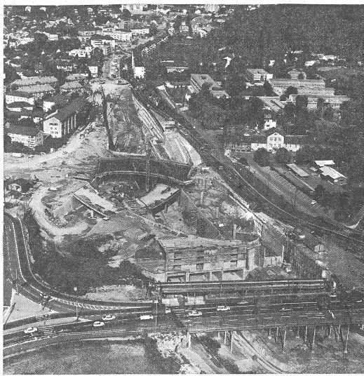
Baustelle der Expressstrasse SN 1 auf dem Milchbuck mit dem Portalgebäude des Milchbucktunnels und dem Kreuzungsbauwerk; im Hintergrund der bereits zugedachte Tunnel Winterthurerstrasse der SN 1 (Photo Comet)
