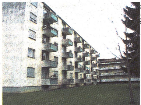
Diese Häuser sollen demnächst abgerissen werden.
