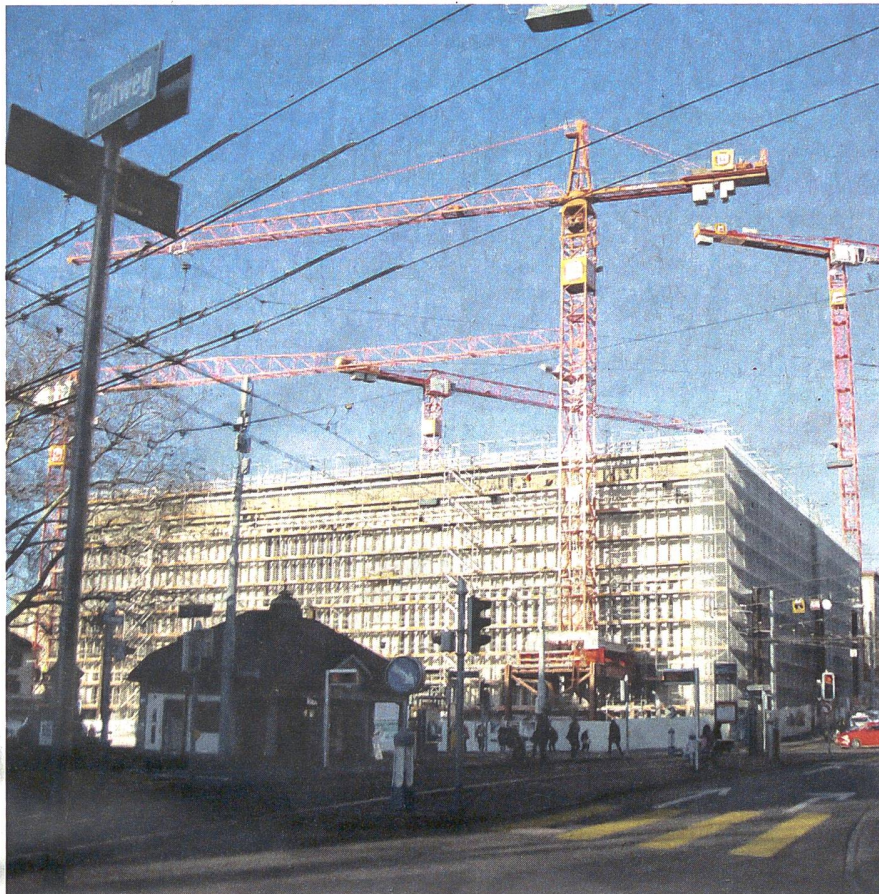
Hier entsteht das grösste Kunstmuseum der Schweiz.
