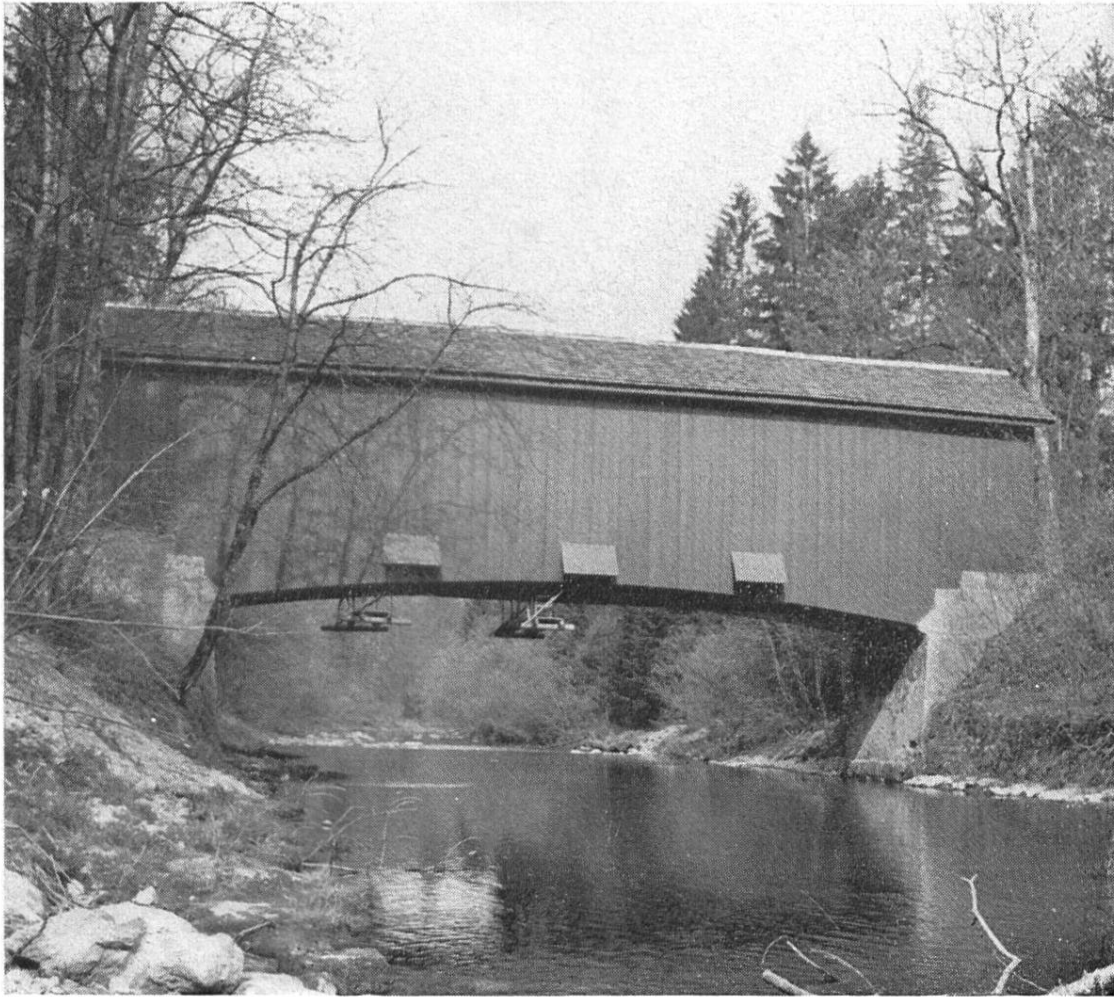
Die Kyburgbrücke im heutigen Zustand. Photo Hans Häberli, Bauamt der Stadt Winterthur, 21. April 1976.
