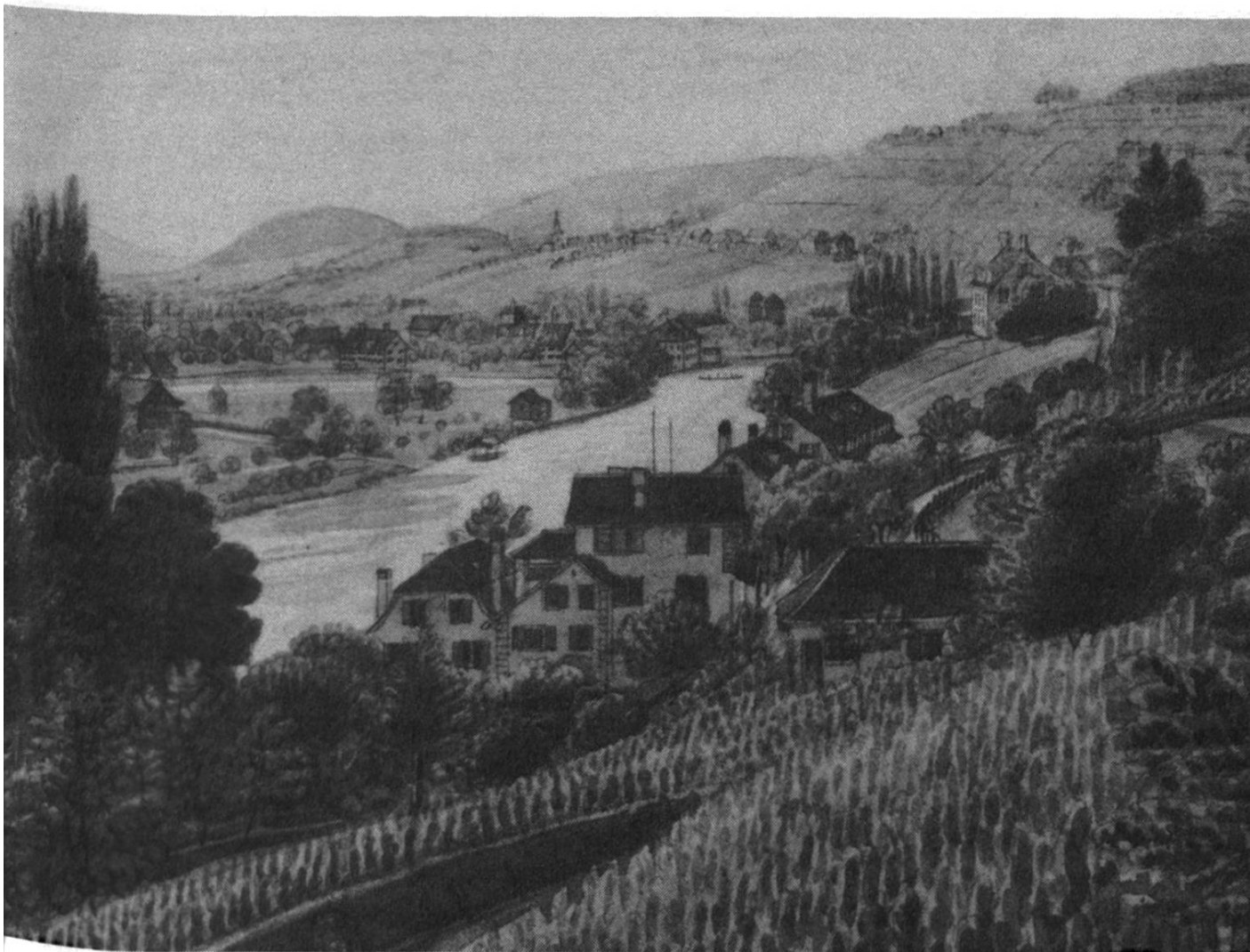
Das Gelände nördlich der Wasserwerkstrasse
