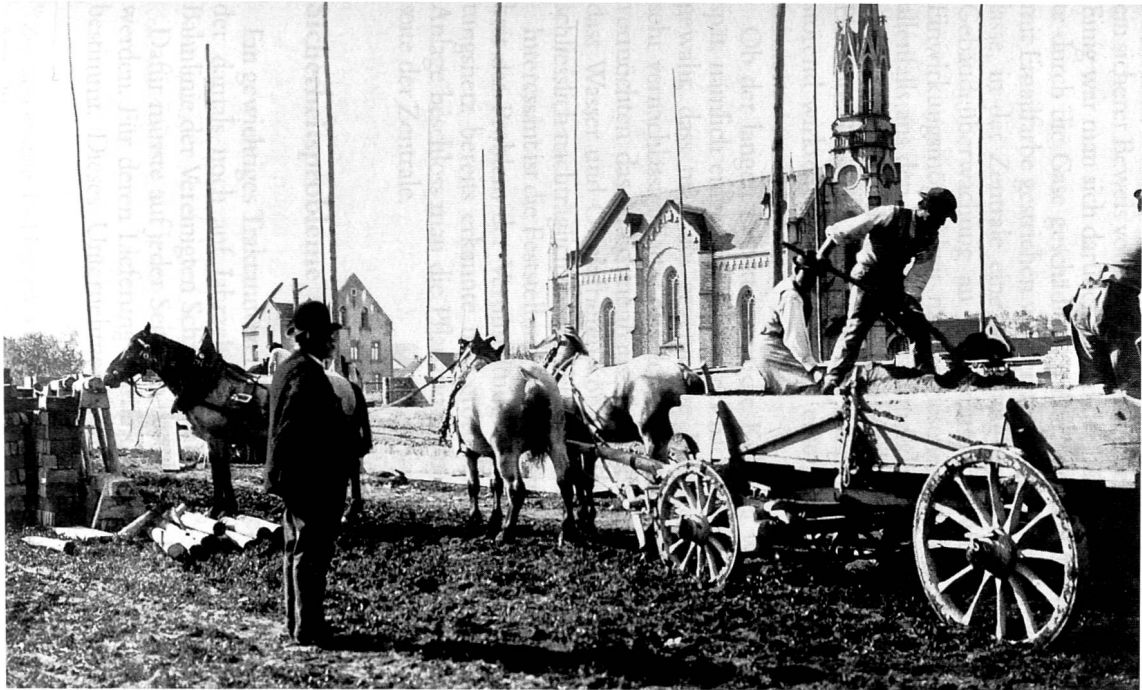
Die Bauarbeiten für das technisch vorausweisende Elektrizitätswerk erfolgten noch in herkömmlicher Weise mit Muskelarbeit und Pferdekraft. Photo Julius Gujer (Paul Kläui-Bibliothek).
